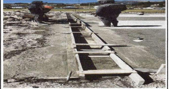
Foto 2: Reparación de cuneta de concreto
